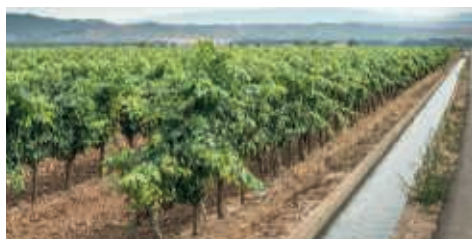
A mise en place de canaux d'irrigation
